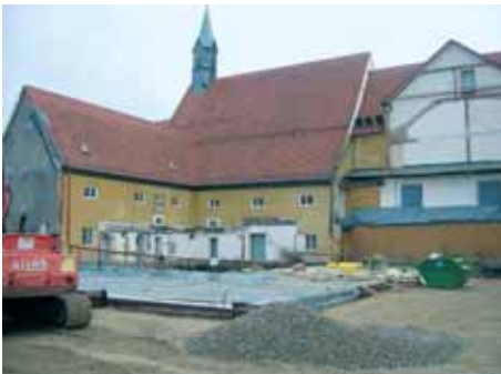
Keller fertig betoniert
