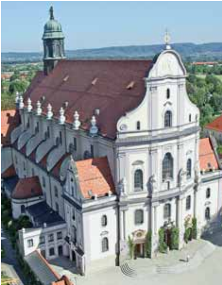
Blick vom Baukran auf die Basilika St. Anna
