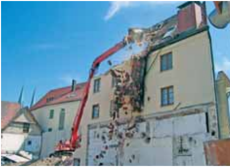
Abriß der Zentralbibliothek/Brauerei
