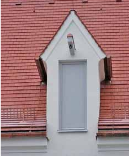
Dachgaube mit Lastenfirst nach historischem Vorbild
