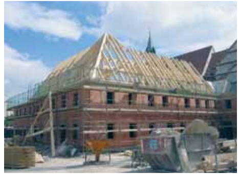
Dachstuhl vor der Vollendung
