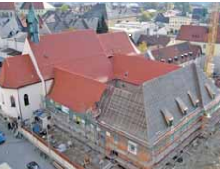
Dacheindeckung schreitet voran
