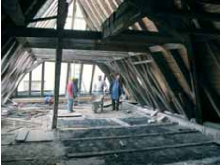
Barockes Dachwerk wird freigelegt
