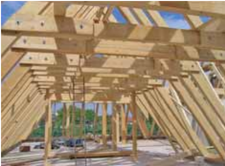
Neuer Dachstuhl am Konventgebäude
