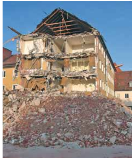
Abriß des Konventgebäudes 2006
